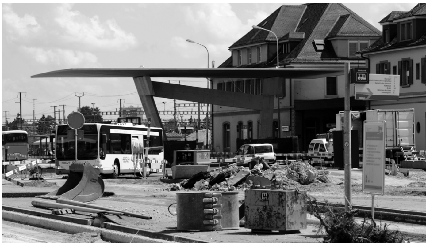
Der Umbau des Bahnhofplatzes Solothurn war auch für den BSU eine Herausforderung.
